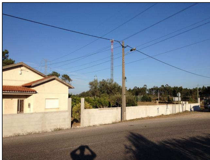
Foto 5 – Ponto de Medição Acústica R5 localizado em Tentúgal (Ribafornos), junto de habitação com um piso e a cerca de 50m a Norte do eixo da Linha da REN em análise (Vão entre o Poste 100 e o Poste 101 da Linha); (Coordenadas Google Earth: 40.272098° ; -8.606101°).
